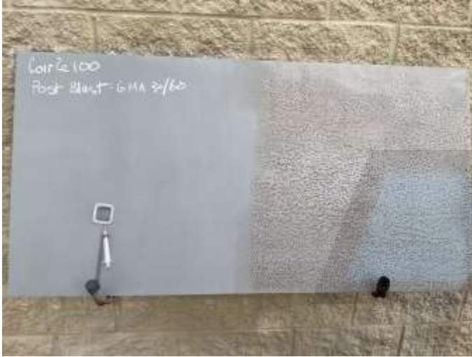
Después del granallado Panel GMA Garnet 30/60
