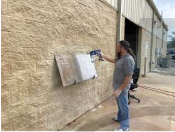
Aplicación Corr-Ze™ 200 (gel) WFT 20 mils
