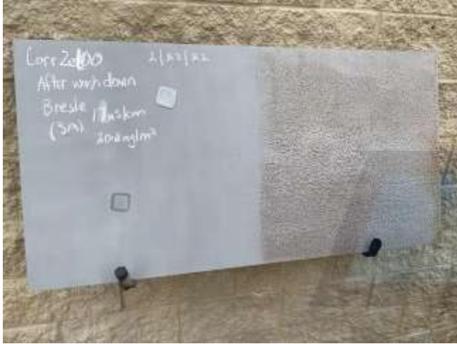
Corr-Ze™ 100: Después del lavado.
