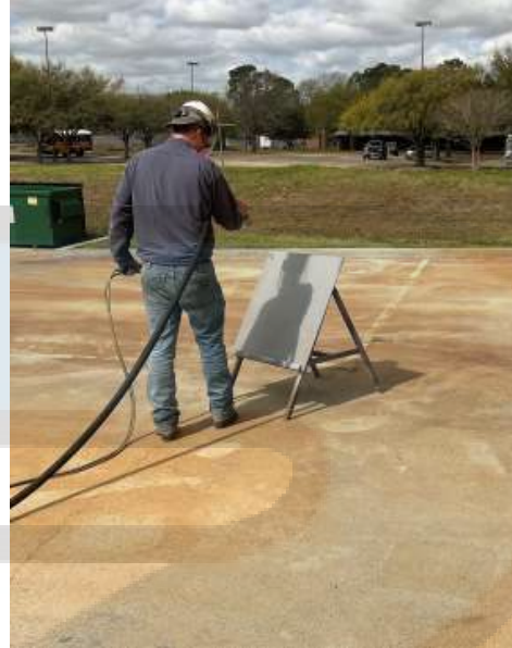
Granallado en seco con silicato de hierro Black Diamond
