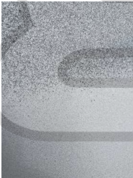
Sustrato Después del Chorreado Superior: Escoria de Cobre Inferior: Condición Original
