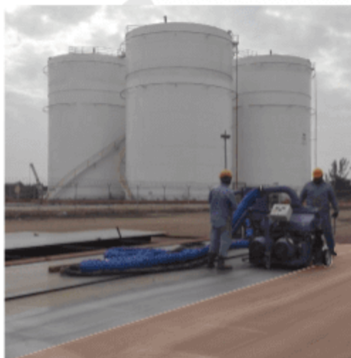
LIMPIEZA DE PLACAS DE ACERO CLEANING OF STEEL PLATES
